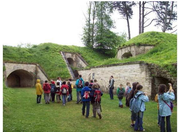
Une cour intérieure
